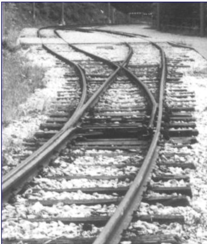
E' stato totalmente sostituito l'armamento dotando lo stesso di particolari accorgimenti tecnici atti a limitare le vibrazioni e la rumorosità al transito delle vetture tranviarie.
